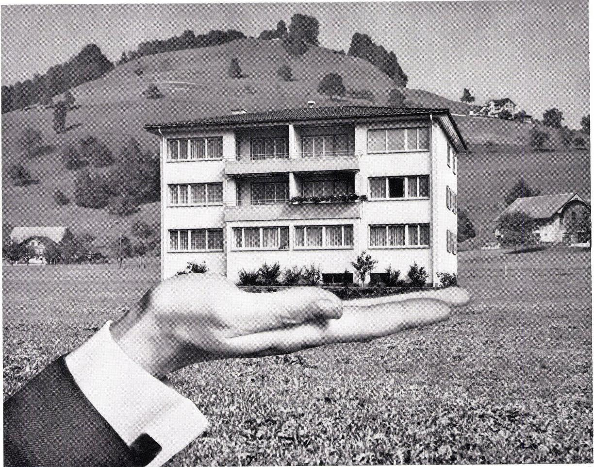
Hochwertige Materialien mit ausgezeichneten Isoliereigenschaften führen zu immer leichteren Bauelementen. Durch die Einsparungen möglich werden: beim Gewicht der Konstruktionen – bei der Bauzeit – bei den Baukosten. Wie bei diesem Haus, bei dem für die Fassadenwände Holzwolle-Leichtbauplatten und Beton miteinander kombiniert wurden (Mantelbetonweise). Im Kern
