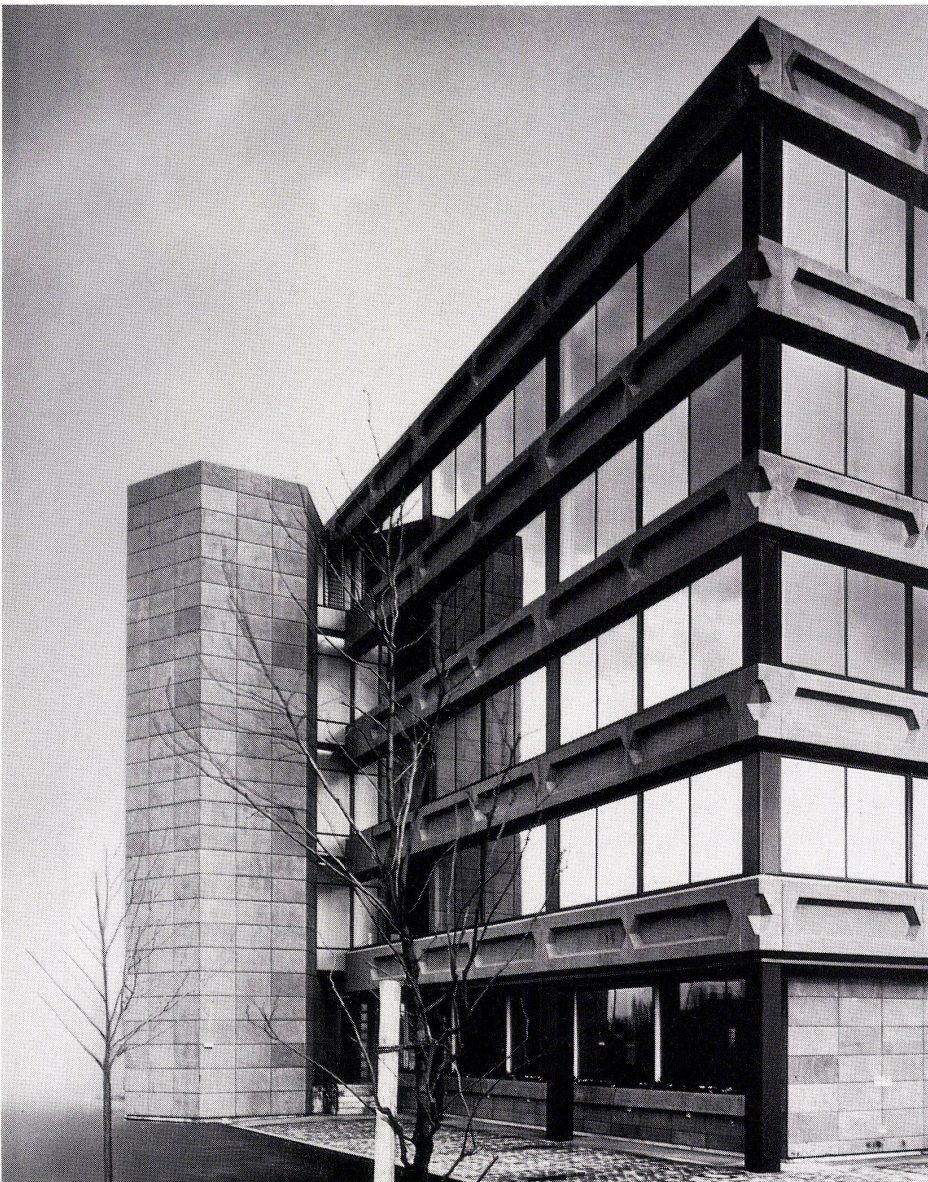
5 Ansicht mit außenliegendem Nottreppenhaus. Vue d'ensemble avec cage d'escalier de secours située à l'extérieur. View showing outside emergency staircase.
