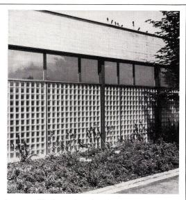
Die Verwendung von Glasbausteinen bei Hallenschwimmbädern gibt diesen Bauten eine moderne, großzügige Note. Die Konstruktion ist äußerst stabil dank den armierten Fugen. Diese Glasbausteinwände isolieren sehr gut gegen Kälte und Schall. Sie bieten auch hohe Sicherheit gegen Steinwürfe oder ähnliche gewaltsame Einwirkungen. Die diffuse Lichtstreuung im Innern, verbunden mit der Sicherheit gegen jeden Einblick von außen, schafft eine angenehme Atmosphäre.
