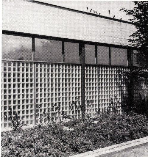
Die Verwendung von Glasbausteinen bei Hallenschwimmbädern gibt diesen Bauten eine moderne, großzügige Note. Die Konstruktion ist äußerst stabil dank den armierten Fugen. Diese Glasbausteine isolieren sehr gut gegen Kälte und Schall. Sie bieten auch hohe Sicherheit gegen Steinwürfe oder ähnliche gewaltsame Einwirkungen. Die diffuse Lichtstreuung im Innern, verbunden mit der Sicherheit gegen jeden Einblick von außen, schafft eine angenehme Atmosphäre.
