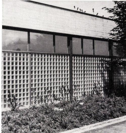
Die Verwendung von Glasbausteinen bei Hallenschwimmbädern gibt diesen Bauten eine moderne, großzügige Note. Die Konstruktion ist äußerst stabil dank den armierten Fugen. Diese Glasbausteinwände isolieren sehr gut gegen Kälte und Schall. Sie bieten auch hohe Sicherheit gegen Steinwürfe oder ähnliche gewaltsame Einwirkungen. Die diffuse Lichtstreuung im Innern, verbunden mit der Sicherheit gegen jeden Einblick von außen, schafft eine angenehme Atmosphäre.
