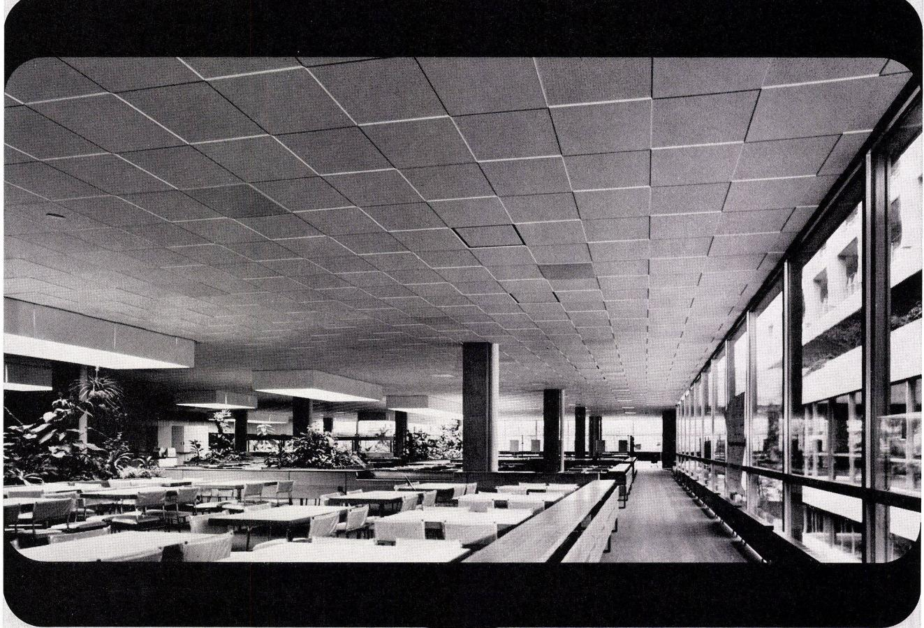
Aha! Schon wieder ein anspruchsvolles Objekt, dessen Decke mit Odenwald-Mineralfaserplatten ausgeführt wurde. 2700 m<sup>2</sup> auf einer Fläche - die gefällige, plastische Wirkung lässt sich nicht übersehen. Außerdem ermöglichen die durchbohrten Platten eine Luftumwälzung von 40'000 m<sup>3</sup> pro Stunde. Alles in allem: Eine betont ange-
