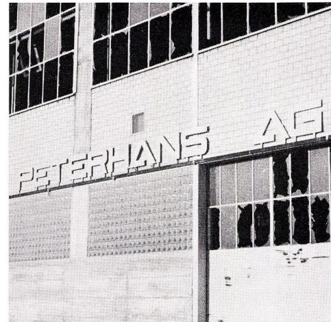
Der Sachschaden, den die Sprengstoffexplosion in Dottikon in der weiteren Umgebung verursachte, war sehr groß. In einer Fabrikhalle wurde der größte Teil der oberen, normalen Verglasung zerstört. Die Glasbausteine im unteren Teil der Wand hielten dem riesigen Druck der Detonationswelle stand und schützten die in der Halle Arbeitenden. Leichte Verletzungen gab es nur durch herabfallende Splitter der oberen Verglasung.
