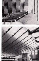
Konzertsaal Schrägwand, Vertikalschnitt Elemente aus NOVOPAN 40 mm, furniert und NOVOPAN Hängedecke
