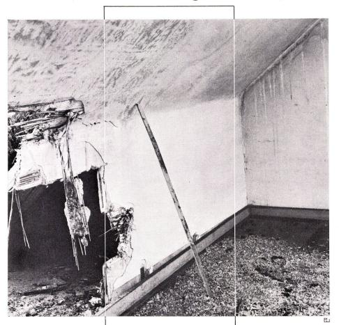
$\dots$  für Wände, Decken, Dachuntersichten und Verschalungen sind von höchstem Wert, weil sie gegen Feuer eine schützende Barriere bilden. Die leichten Seccopan-Trockenbauplatten aus Gips erfüllen die Anforderungen an «feuerhemmende» Bauteile. Das bestätigen die in Brandversuchen ermittelten Prüfungsresultate auf Feuerwiderstandsfähigkeit (W $_{\rm P}$ ) in Minuten: Seccopan 25 mm: W $_{\rm F}=49$  Min. Seccopan 40 mm: W $_{\rm F}=108$  Min.
