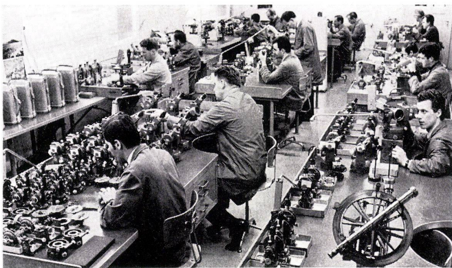
Ein Blick in die Theodolitenmontage der Firma Kern in Aarau. Im Vordergrund rechts ein Triangulationstheodolit, gebaut im Jahre 1835 im Auftrag von General Dufour (Dufourkarte).
