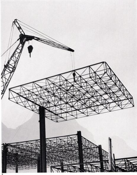
8 Anschluß der Raumtragwerke an die Stütze. Jonction au pilier. Joining on the pillar.
