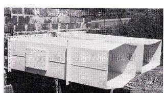
7 Kanäle und Rohrleitungen in der Stockwerkshälfte eines Laborturmes. Von links: Zulufkanal, Abwasser, Wasser, NDD, Kondensator, Preßluft, Abluftkanal aus PE mit Digestoren. Anschließend Elektrostraße (Kabelpritschen).
