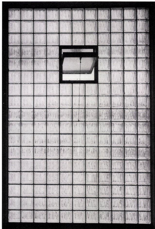
Weil mit Glasbausteinen Treppenhauswände von 150 bis 200 cm Breite und einer Höhe bis 10 m **ohne** Querriegel ausgeführt werden können.
