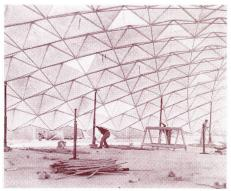
Tankstellen der Imperial Oil Comp. in Toronto, Windsor, Hull und Quebec in Kanada. Jedes Element, sechseckig mit ca. 9 m Durchmesser, ist aus sechs gleichen, selbsttragenden Komponenten zusammengesetzt, die untereinander verbunden und über Zugglieder mit dem zentralen, stützenden Mast verbunden sind.
