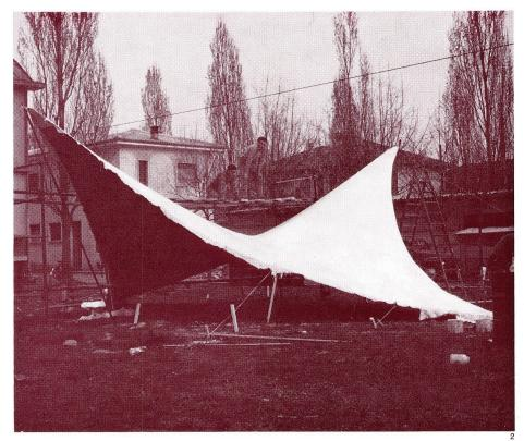
Herstellung einer HP-Schale aus glasfaserverstärktem Kunststoff auf einer gedehnten Membran / Fabrication d'une coque HP en plastique stratifié aux fibres de verre sur une membrane étendue / Fabrication of an HP shell of glass-reinforced plastic on a tensed membrane
