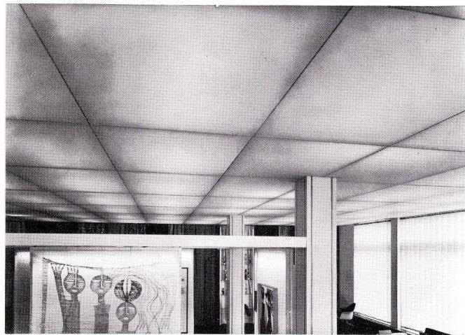
Die Lichtdeckenelemente lassen sich auch vertikal als Lichtwände aufstellen.
