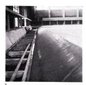
Abdichtung eines Flachdaches aus Trapezblechen.
