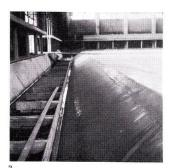
Abdichtung eines Flachdaches aus Trapezblechen.
