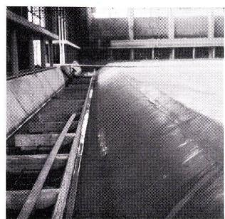
1 Abdichtung eines Flachdaches aus Trapezblechen.
