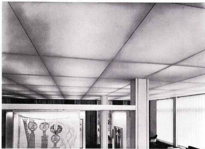
Die Lichtdeckenelemente lassen sich auch vertikal als Lichtwände aufstellen.
