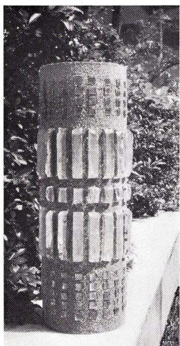
Glasbeton besteht aus zugehauenen Glasstücken, eingebettet in armierten Beton. Struktur und Brillanz des Lichtes entsprechen den heutigen Anforderungen an ein modernes Bauelement.
