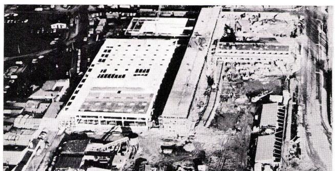
**Deutschland — Flughafen Hamburg, Luftfrachtgebäude** Verhütung von Beschädigungen durch Dacharbeiten: 10 000 m<sup>2</sup> Roofmate wurden beim Bau des Luftfrachtgebäudes des Flughafens Hamburg verwendet. Roofmate wurde besonders deshalb gewählt, weil es gegen die Feuchtigkeitseinwirkung, wie sie bei umfangreichen Dachbaurbeiten entsteht, unempfindlich ist.
