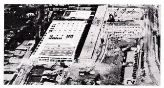
Deutschland — Flughafen Hamburg, Luftfrachtgebäude Verhütung von Beschädigungen durch Dacharbeiten: 10 000 m² Roofmate wurden beim Bau des Luftfrachtgebäudes des Flughafens Hamburg verwendet. Roofmate wurde besonders deshalb gewählt, weil es gegen die Feuchtigkeitseinwirkung, wie sie bei umfangreichen Dachbauarbeiten entsteht, unempfindlich ist.
