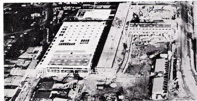
**Deutschland – Flughafen Hamburg, Luftfrachtgebäude** Verhütung von Beschädigungen durch Dacharbeiten: 10 000 m<sup>2</sup> Roofmate wurden beim Bau des Luftfrachtgebäudes des Flughafens Hamburg verwendet. Roofmate wurde besonders deshalb gewählt, weil es gegen die Feuchtigkeitseinwirkung, wie sie bei umfangreichen Dachbauarbeiten entsteht, unempfindlich ist.
