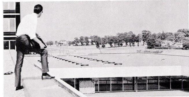
**Schweiz – Flughafen Genf** Verhinderung von Wärmedehnung: 10 000 m<sup>2</sup> Roofmate wurden im neuen Flughafengebäude Genf verlegt, weil es die bei Wärmedehnung auftretenden Spannungen in der Dachterrasse verhindert.
