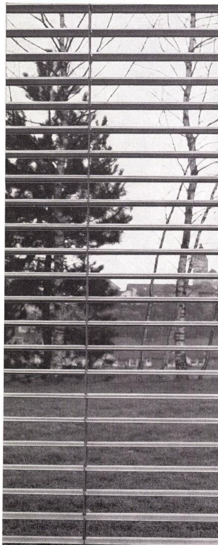
Typ 80, randgebördelte Lamellen, weite Rasterbildung mit Horizontalkontur. Bessere, unbehinderte Sicht von innen nach außen.
