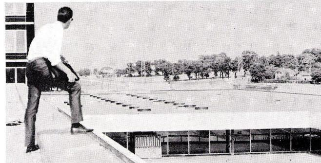
**Schweiz – Flughafen Genf** Verhinderung von Wärmedehnung: 10 000 m<sup>2</sup> Roofmate wurden im neuen Flughafengebäude Genf verlegt, weil es die bei Wärmedehnung auftretenden Spannungen in der Dachterrasse verhindert.
