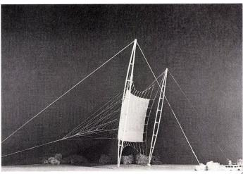
2. Die rhombische Verformung des in der Ebene gleichmaschigen quadratischen Netzes soll möglichst gering und von der mittleren Masche ausgehend achsensymmetrisch sein.
