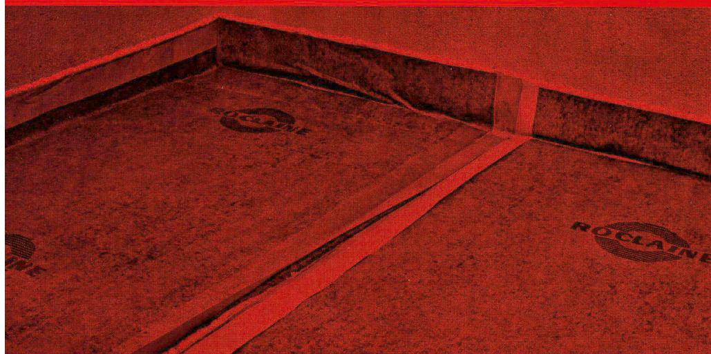
Sauberes Verlegen, dichte Stöße und korrekte Randstreifen verhindern Schallbrücken.
