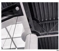
20 Feuerschutz-Verkleidung bei der Außenstütze, rechts verglaste Außenwand mit Lamellenstorentasche.
