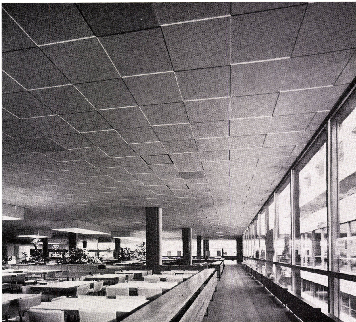
2500 m 2 Lüftungsdecke. Personalrestaurant Firma J. R. Geigy A.G. Burckhardt Architekten SIA
