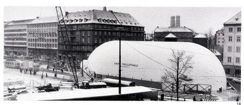
13 Bau eines Wohnblocks unter einer Traglufthalle.
