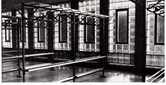
Glasbausteine bieten viel mehr Gestaltungsmöglichkeiten als die konventionelle Verglasungsart. Lichtstreuung, Isolation, Schalldämmung, Sicherheit gegen Feuer und Einbruch und dauernde Glasklarheit stempeln den Glasbaustein zum modernen exklusiven Bauelement.
