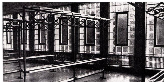
Glasbausteine bieten viel mehr Gestaltungsmöglichkeiten als die konventionelle Verglasungsart. Lichtstreuung, Isolation, Schalldämmung, Sicherheit gegen Feuer und Einbruch und dauernde Glasklarheit stampeln den Glasbaustein zum modernen exklusiven Bauelement.
