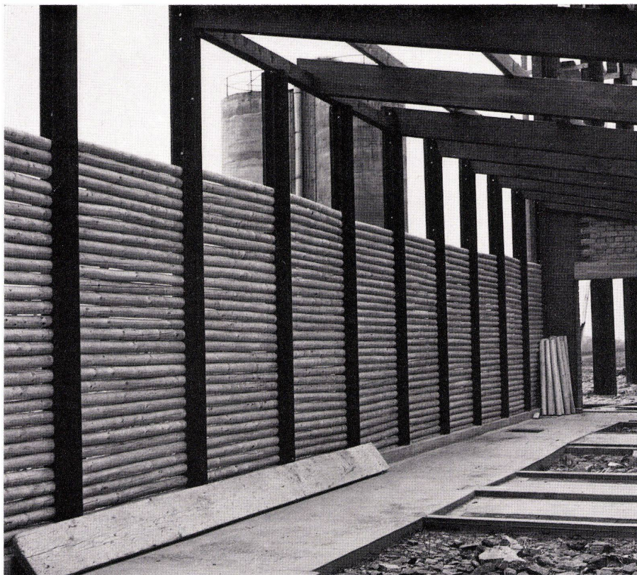
5 Wandausfachung des Stallgebäudes im Rohbau. Garniture murale du bâtiment-écuries dans la construction brute. Wall detailing of stables under construction.
