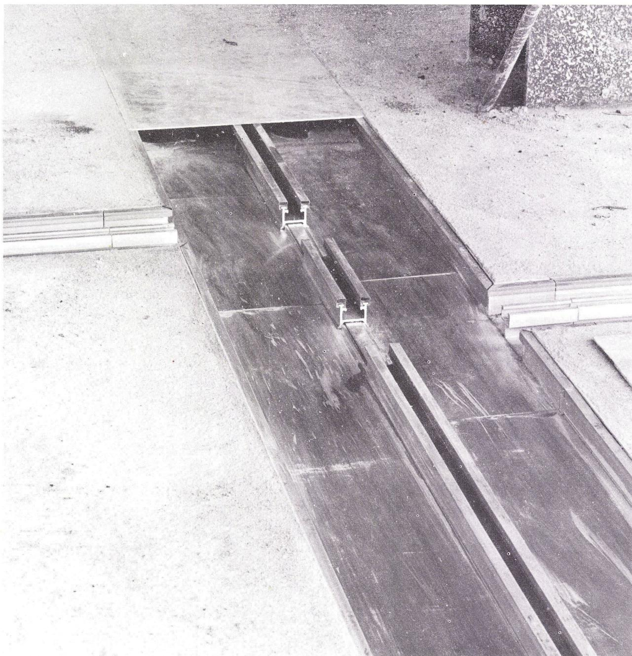
**Plaques de couverture** fixées par bandes magnétiques (sans vis)
