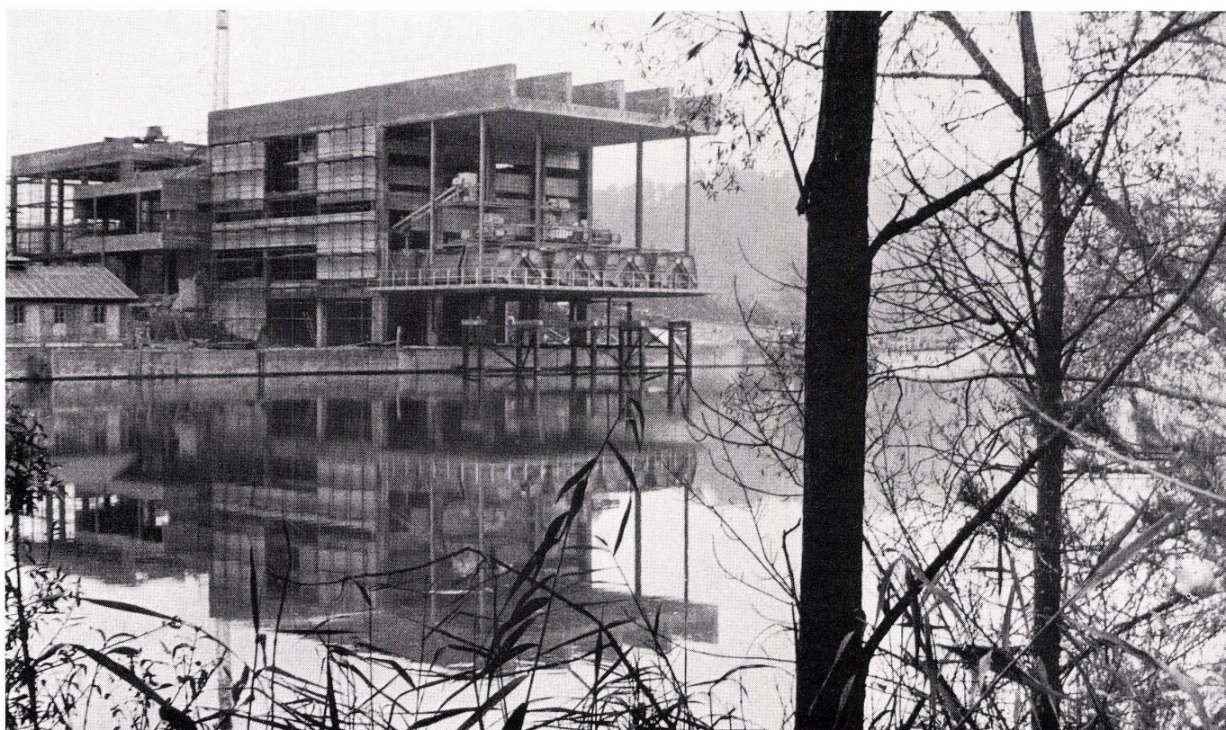
12 Gebäude für die Schlamm-trocknung. Das Gebäude krägt über die Rhone aus, um den getrockneten Schlamm auf Schiffe verladen zu können. Bâtiment pour le séchage de la boue. Le bâtiment est en saillie sur le Rhône afin de pouvoir charger la boue desséchée sur les barges. Building for sludge drying. The building towers over the Rhone, this enabling the dried sludge to be loaded onto ships.
