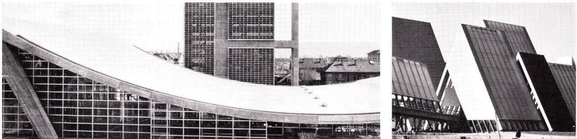
Sarnafil ist eine armierte, auf Weich-PVC aufgebaute Kunststoffhaut. Es wird in mehreren Lagen bis 2mm stark hergestellt. Es ist elastisch, mechanisch und gegen UV-Strahlung widerstandsfähig und witterungsbeständig.
