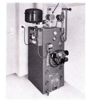
Einbaubeispiel für Sven-Kalkschutzapparat.
