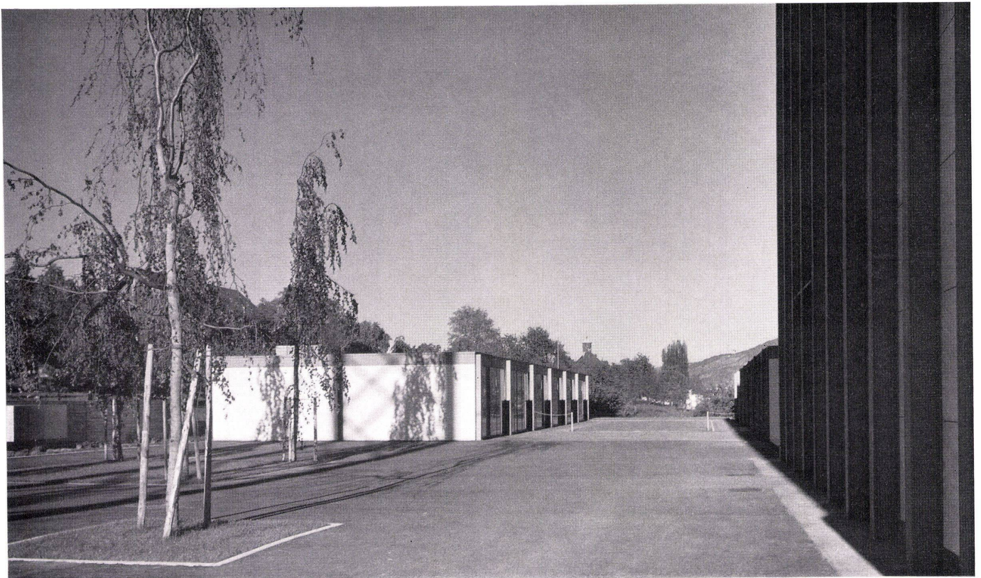
Kirchenplatz. Im Hintergrund links Pfarrheim, rechts Pfarrhaus. Parvis. A l'arrière-plan à gauche, le hôte paroissial, à droite, la cure. Church square. In background, parsonage, right, parish hall.
