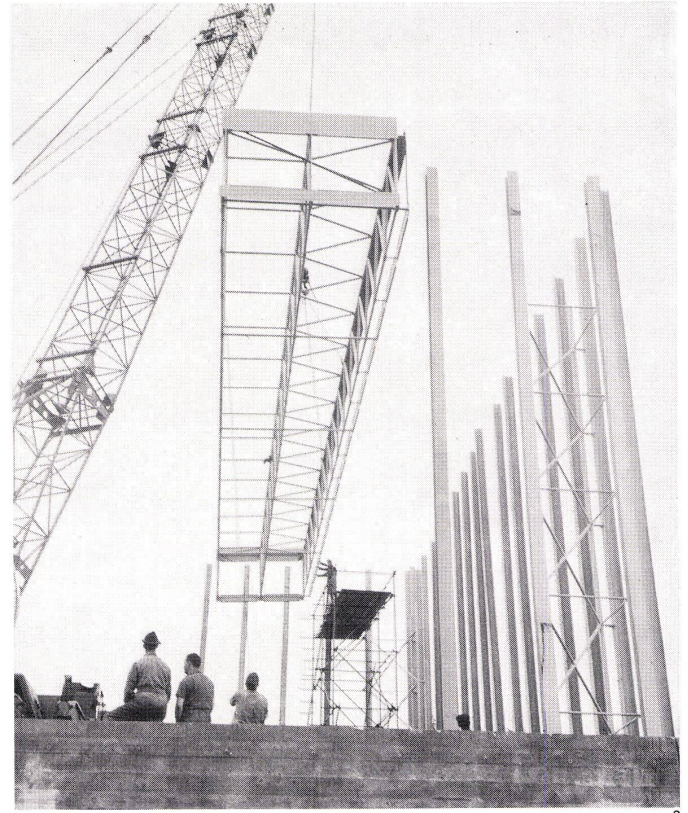
2 Montage der Fachwerkträger. Montage des appuis de treillis en espace. Assembly of lattice girders.
