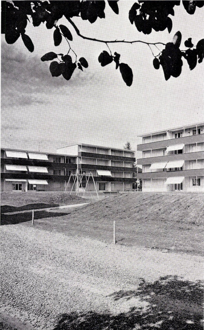
Beispiel: Überbauung Neu Hof Cham, für die Papierfabrik Cham AG
