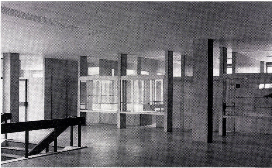
Treppenaufgang mit Flur im Lehrtrakt. Escaliers et dégagements dans le bâtiment des cours. Stairs with hallway in the classroom tract.
