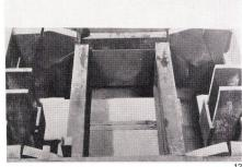
7-10 Zusammensetzen der geschoßhohen Stützenabschnitte.
