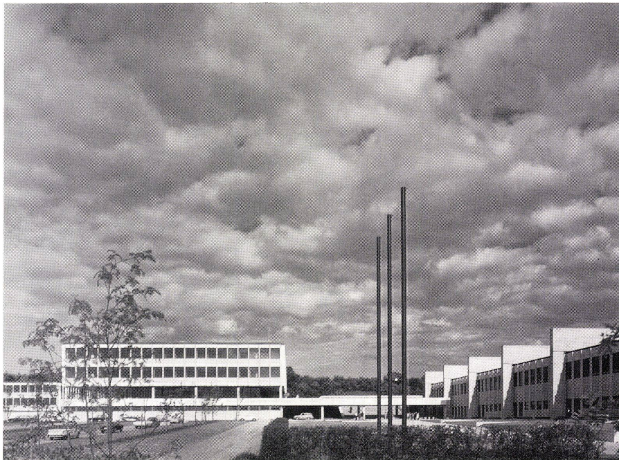
Haupteingang. Ansicht vom Parkplatz. Rechts Sport- halle, links Lehrtrakt, dazwischen Haupteingang mit Aufgang zum Forum.
