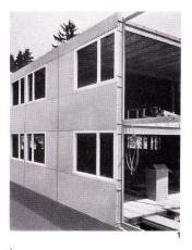
1 Montage der Außenwände aus 12 cm dicken Durisol-Fassadenplatten, die außen mit einem Zementputz versehen sind.
