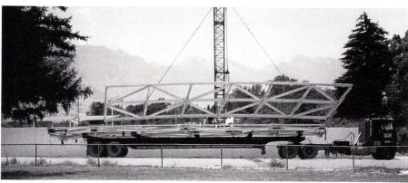
Auf einem Spezialtieflader werden die Gitterträger aus den Konstruktionswerkstätten auf den Bau transportiert und dort mittels eines Kranes montiert. Chargées sur camion à plateforme surbaissée, les poutres en treillis sont transportées de la fabrique au chantier, où elles sont montées avec une grue. The trellice girders are transported from the shops on a special mobile hoist to the construction site and there assembled by means of a crane.
