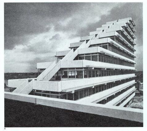
Hochhaus 6-8 mm, Flachbau 8-10 mm, beides als Verbundverglasung mit Neoprene-Dichtung.
