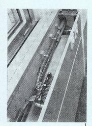
Geöffnete Fenstertrasse mit Leitungs-führung 220/380 V, Telephon- und Signalanlagen. Zwischen Trasse und Fenster Schlitze für Blaslufteinführung. Allège ouverte avec vue sur les gaines d'installations (220/380 V), de téléphone enregistrement et d'émission. Entre la zone d'installations et les vitrages se trouvent des fentes pour l'amenée d'air climatisé.
