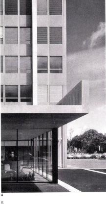
5 Fassadenausschnitt mit überhöhtem Erdgeschoß. Die metallverkleideten Betonpfeiler stehen optisch auf dem Vorplatz und werden horizontal durch helle Streifen zur Gliederung des Platzes im Wasserbecken weitergeführt.
