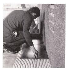
beiden Anwendungen ist eine ausnivellierte Montagefläche unerlässlich, weil die 2-3 mm dicke Klebstoffschicht keine grösseren Unebenheiten (Wellen!) ausgleichen könnte. Für das Verlegen eignen sich verschiedene der handelsüblichen Klebstoffe. Um jedoch ein einwandfreies Kleben zu garantieren, verwenden Sie am besten unseren eigens dafür entwickelten Klebstoff T26. Er besitzt
