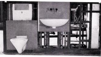
der Zweietappenmontage bestehen. Zuerst wird der Block mit den Leitungen versetzt. Die Apparatemontage erfolgt erst später, in einer zweiten Etappe. Eventuell wird für die Wannenmontage sogar ein dritter Gang notwendig.
