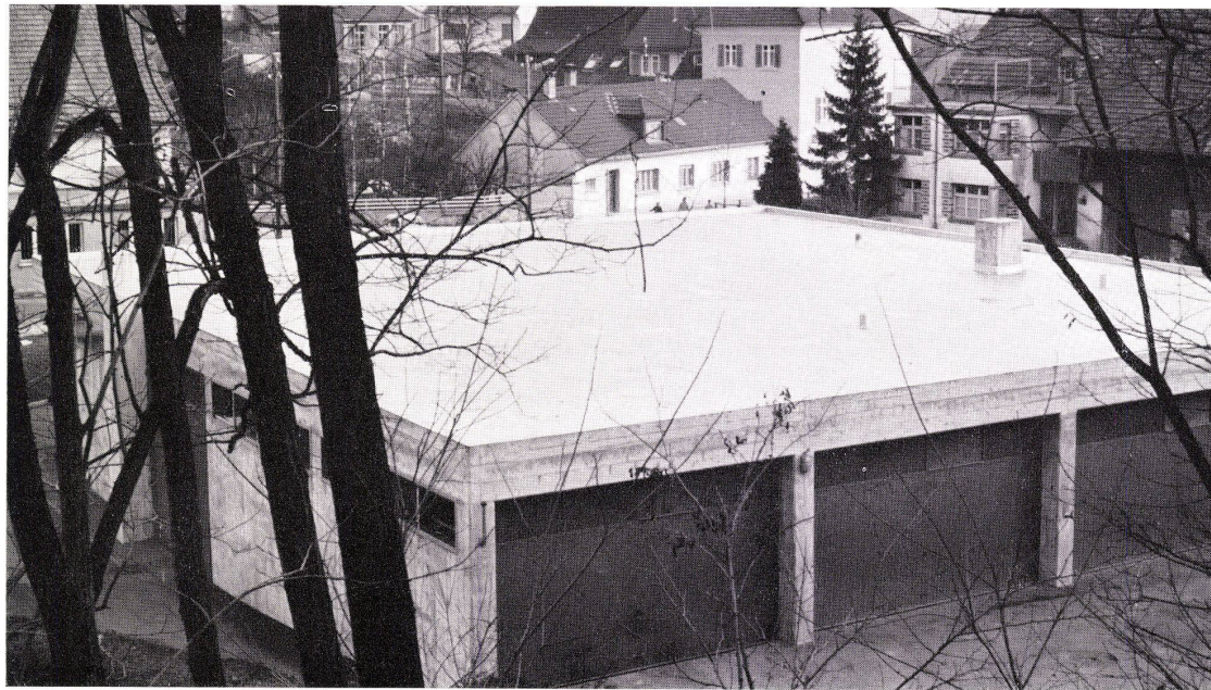
werkgebäude hägendorf fanaprene + alu, 1961 arch. h. zaugg, olten
