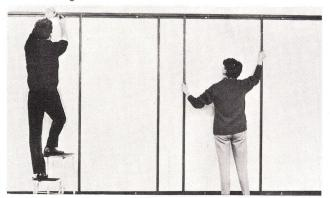
Der Trägerrahmen wird am Bestimmungsort an der Wand ausgerichtet — die vorhandene Lochung der Trägerschiene dient als Lehre für das Anbringen der Dübel.
