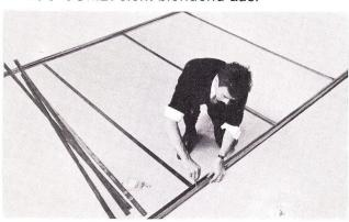
Verschrauben der Eisenprofile auf dem Zimmerboden nach dem Baukastensystem.
