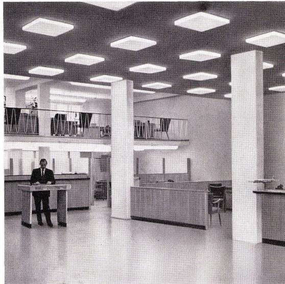
Größen der Deckenplatten. Die flache Konstruktion gewährleistet die Montage auch bei geringer Einbautiefe. Unterschiedliche Abdeckwanzen und Formen, die sich auch zu Lichtbändern und Feldern zusammensetzen lassen, ermöglichen eine variable Gestaltung. Zur Erleichterung der Montage werden Befestigungsteile
