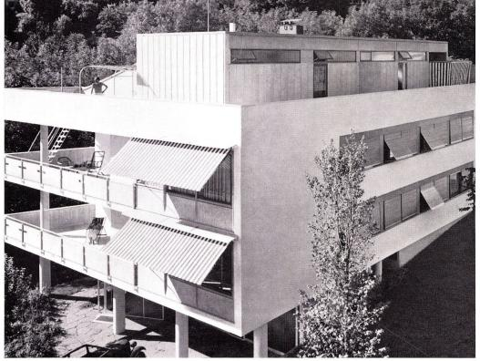
Asbestzementprodukte «ETERNIT» sind im modernen Wohnungsbau vielseitig verwendbar. Naturgraue, ebene Asbestzementplatten eignen sich für Fassaden, Brüstungen und Balkone. Sie sind wartungsfrei, wetterfest und wirtschaftlich. Unser Bild: Mehrfamilienhaus im Doldertal in Zürich mit ebenen Asbestzementplatten für Balkonbrüstungen und Storenschutz. Architekt: Prof. Alfred Roth, Zürich.
