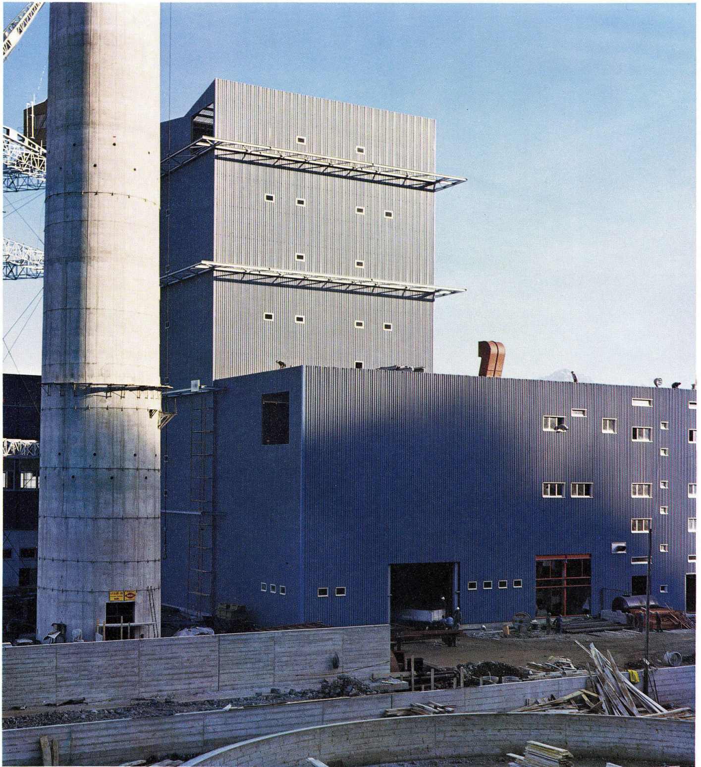
Thermische Kraftzentrale Vouvry mit gewellten Alucolux-Bändern verkleidet
