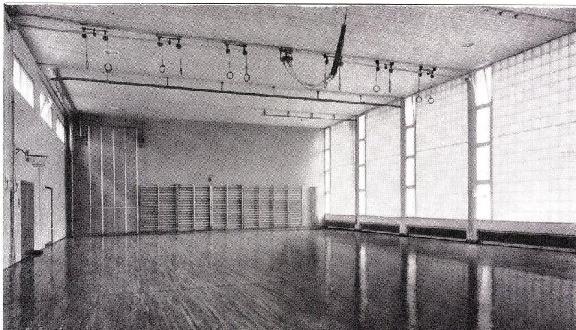
Lieferung und Montage von Glasbausteinvänden aus blendungsfreien, hochisolierenden, ballfesten Glasbausteinen, inklusive den damit verbundenen Metallbauarbeiten, wie Lüftungsflügel, Türzargen, Anschlußprofile usw.
