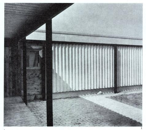
Geschoßhohe Wellasbestplatten begrenzen die Stauräume des Viehstalles. Das tragende Skelett besteht aus Stahlprofilen, die vor die raumabschließenden
