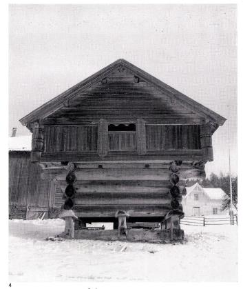
Das Stabbur von Nordre Gjellerud in Numedal (S. 122; 3, 4) zeigt eine neue Absicht, die Konstruktion eindeutig als Hauptelement hervorzuheben. Die konsequente Verwendung von regelmäßig angeordneten gedrehten Pfosten gibt dem Gebäude einen »neuklassizistischen« Charakter. Plastische Kraft und konstruktive Logik wirken hier zusammen, um wahre Monumentalität zu schaffen.
