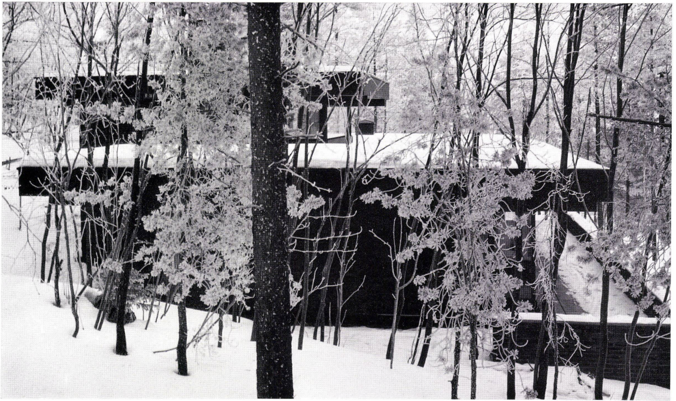
1 Ansicht von Westen. Vue depuis l'ouest. View from west.
