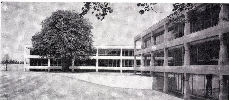
fungieren, die die Bodenplatten aufnehmen. Zwischen je zwei Stützelementen sind Fas-sadenbalken eingehängt, resp. auf Auflager-flächen in den Stützelementen gelegt, auf denen dann wiederum die Geschoßdecken liegen. Diese Fassadenbalken sind mit Hilfe eines Stahlstabes von ca. 3 cm Durchmesser verbunden. Nach Montieren der Elemente wird dieser Stahlstab nachgespannt.
