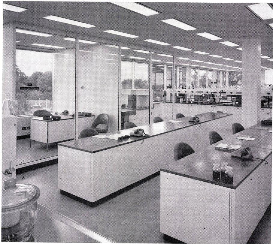
Die Labortische im Forschungsgebäude sind an den Stirnseiten mit weißen Kunststoffplatten beschichtet, haben Teakplatten und chromverbundene Schubläden.
