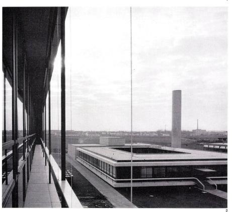
Blick auf die Ostseite des Chemiebaues. Auch hier, wie bei der Plasmaphysik, auskragende Decken, die gleichzeitig Fluchtbalkone sind und den äußeren Sonnenschutz aufnehmen.
